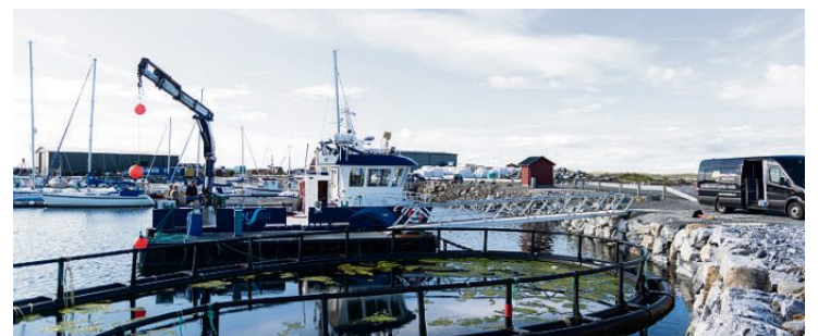
Anlegging av egen flytebrygge på Gårdsøya gjør at fiske- og oppdrettsbåter kan komme og få service på kranene.
